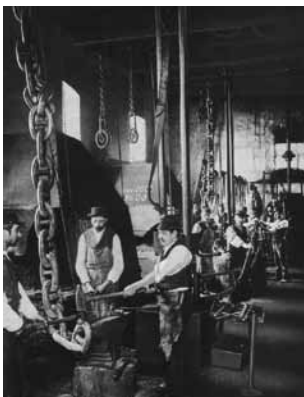
Fragua dedicada a la elaboración de cadenas de ancla 1878
